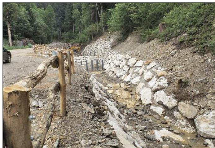
Am **Lauterbach** wurden am Gerinne Instandsetzungen und Erhöhungen der Künette vorgenommen. Bauliche Tätigkeiten erfolgten vom Bereich der Häusl-Kapelle bis zur Unterführung bei der Westbahnstrecke. Die Maßnah-
