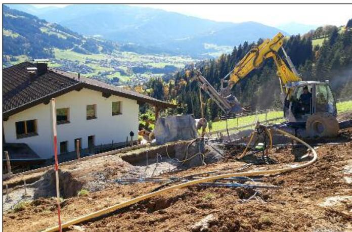
Unübersehbar startete die Lawinenverbauung am Salvenberg. Es werden 5 Reihen Lawinenschutznetze mit insgesamt rund 300 Laufmeter errichtet. Diese Schutz-Bauwerke werden mittels Fundamenten und Zug- bzw. Druckanker im Gelände fixiert. Diese Anker werden bis zu 8,50 m ins Erdreich getrieben, die Zäune weisen eine Höhe von 3 m auf. Im Gesamten werden 2.500 lfm Anker an den Bauwerken verbaut, der Stützenabstand beträgt 6 m.
